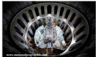
Храмът по време на ремонтните дейности
